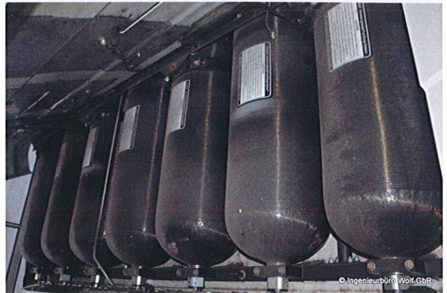
Abb. 4: Wasserstofftankanlage auf dem Dach vorne
